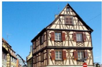
**Le torchis:** Avec la terre argileuse humide mélangée avec de la paille, on peut fabriquer une pâte qui se colle sur des morceaux de bois calés entre des poutres verticales...
