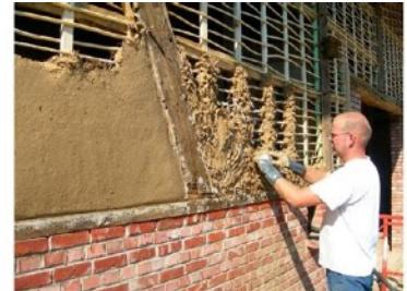
**La terre-paille:** comme le torchis on utilise une structure en bois, avec des ballots paille entre les poutres verticales et de l'argile par dessus, à l'intérieur et à l'extérieur.
